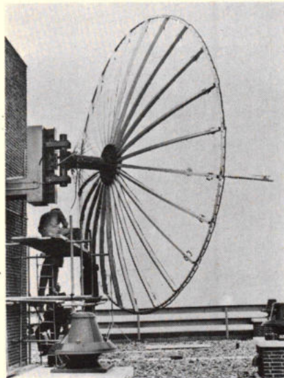
Siemens heeft in Zoetermeer het bestaande CAI-net aangevuld met een paraboolantenne, zodat de aangesloten kijkers nu ook naar het Duitse 1e en 2e TV-net kunnen kijken. De antenne heeft een diameter van 6 m en staat gericht op de 150 km afgelegen zenders Wesel en Kleef. De openingshoek van de 350 kg zware antenne bedraagt 4°; de antennewinst is 30 dB. (foto: Siemens)
